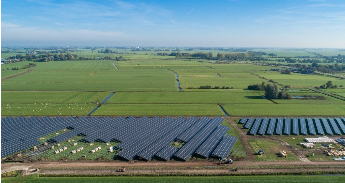
Afbeelding 5: Zonnepark Bûtenpost in aanbouw
